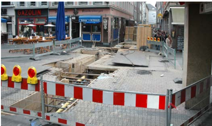
Vorlaufende Umverlegung von Versorgungsleitungen
