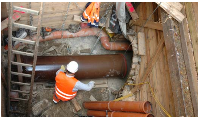
Einbau Kanal in Stollen
