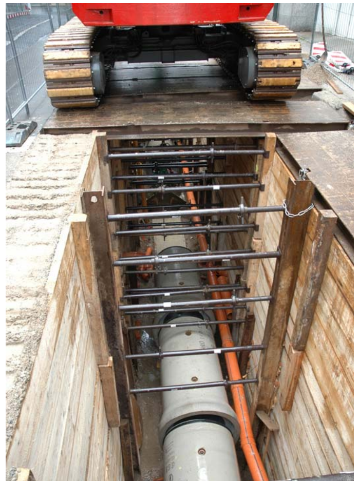
Blick in eine „Wanderbaustelle“
