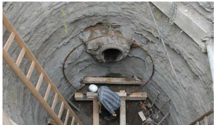
Vorbereitungen zum Stollenanstich
