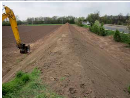
Mit einem Teil der Aushubmassen konnte ein Lärmschutzwall entlang der Autobahn A61 westlich von Erfstadt-Dirmerzheim angeschüttet werden.
