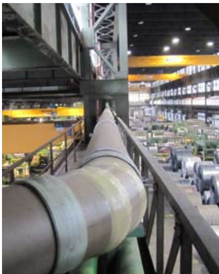
Montage der Sammelleitungen auf den Kranbahntraversen
