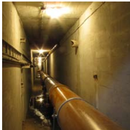
Kabelkanal für die RW-Ableitung
