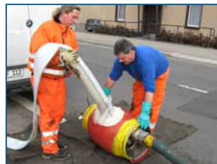
Vorbereitende Installation des Schlauches im Einbaumodul
