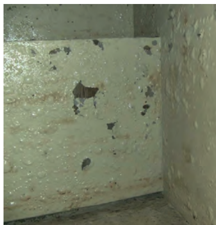
Schadhafte Beschichtung
