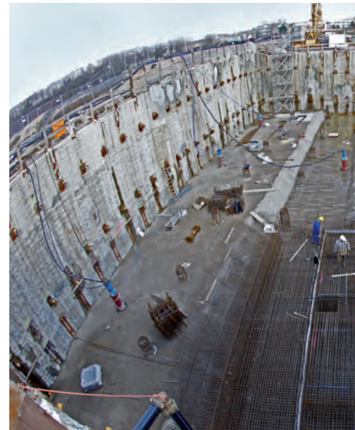
Bewehren der Bodenplatte
