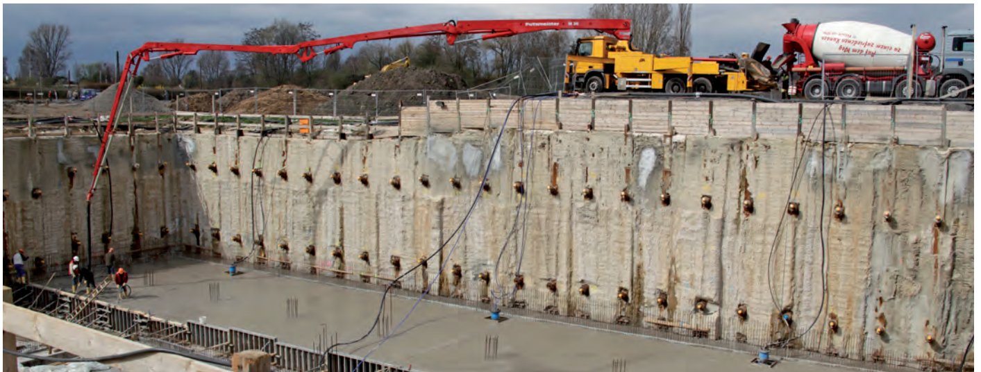
Betonieren der Bodenplatte
