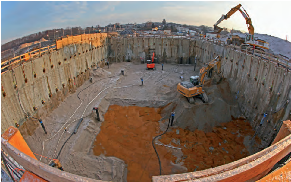
Restaushub Baugrube im Tertiär
